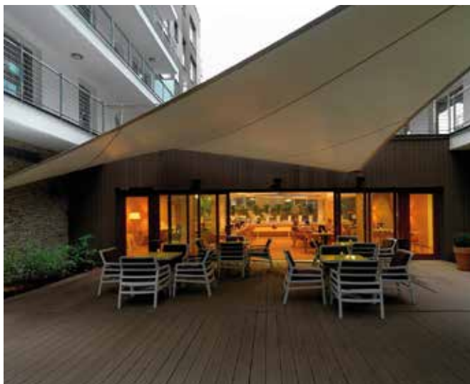
Międzyzdroje / „Rezydencja Flotyła” / taras restauracyjny oraz chodniki
